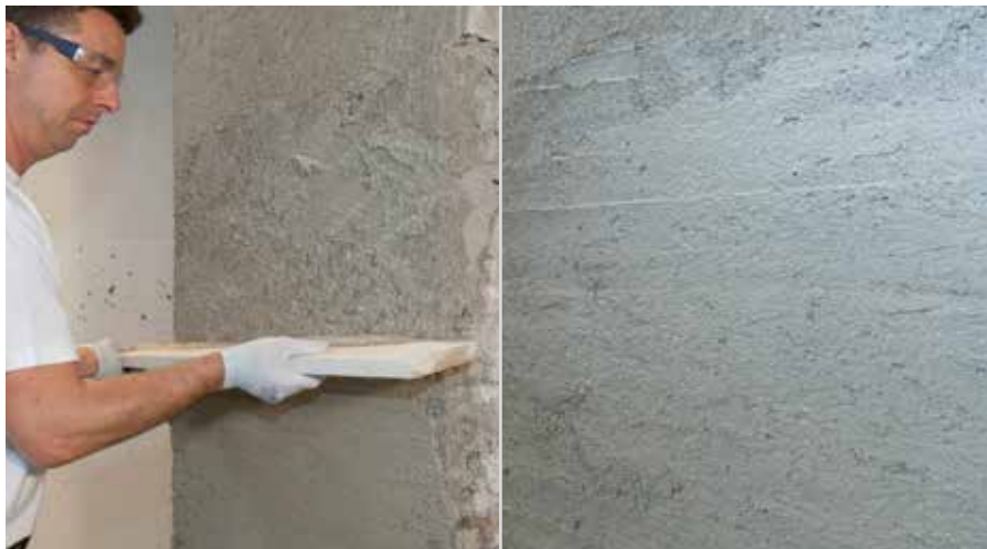
Skidanje/izvlačenje vapnene žbuke
