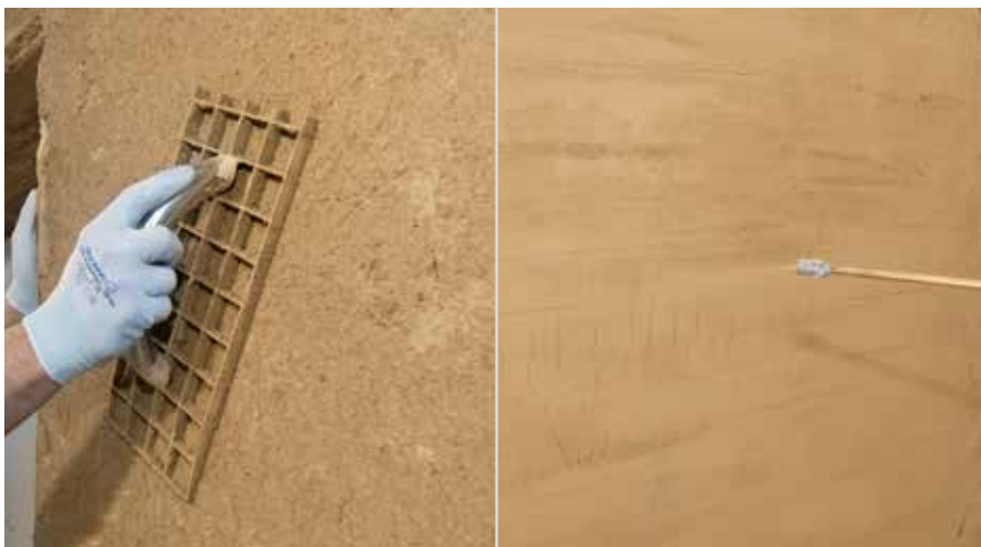
Izravnavanje strugalicom i vlaženje žbuke RÖFIX Geolehm®
