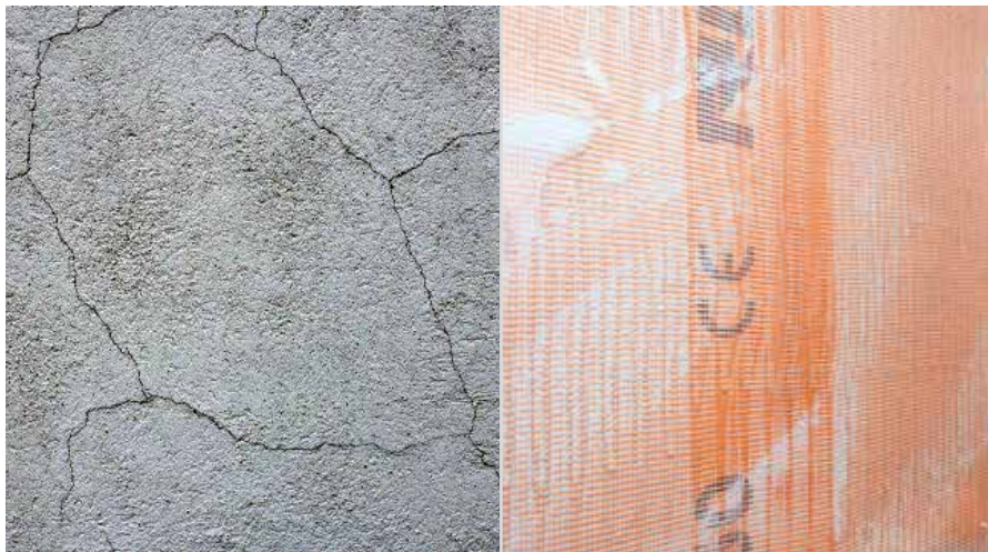
Pukotina nastala puzanjem | RÖFIX Renoplus® Žbuka za renoviranje i izravnavanje (armiranje)
