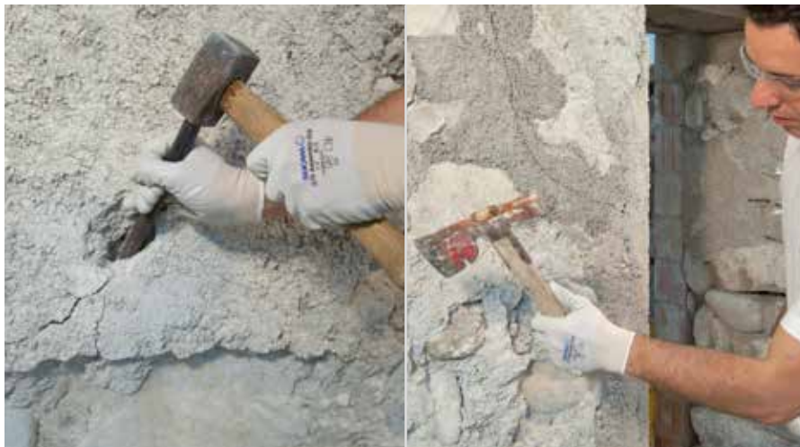
Obijanje stare žbuke
