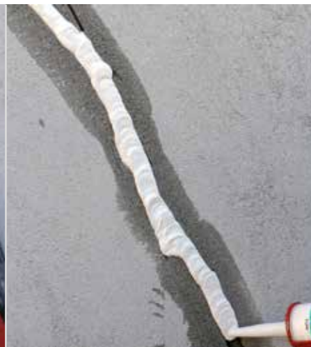
Zatvaranje fuge akrilnim brtvilom-silikonom
