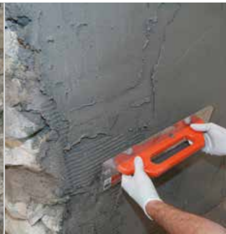
RÖFIX 640 Žbuka za saniranje debljine nanosa od najmanje 20 mm
