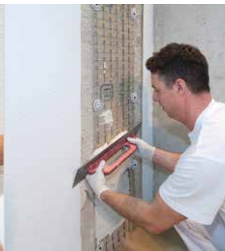
Obrada nosača žbuke (RÖFIX Stucanet)
