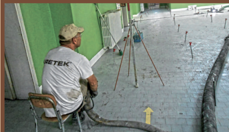
Postupak injektiranja smole
