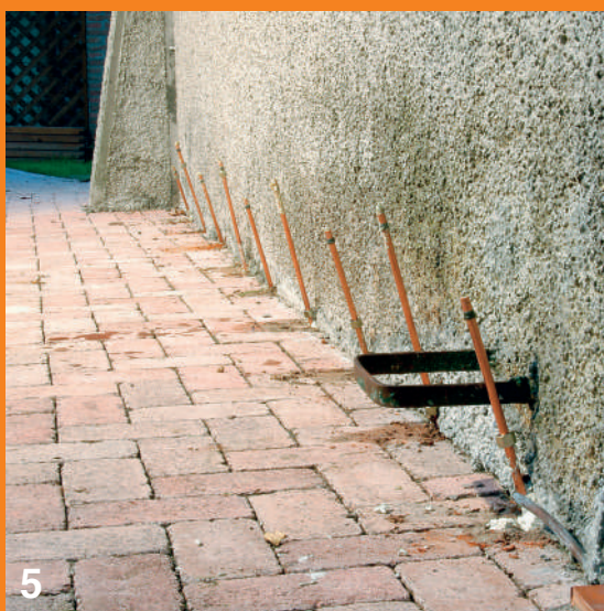
5 ZAVRŠNI RADOVI: BAKRENE CIJEVI REŽU SE U RAZINI PODA
